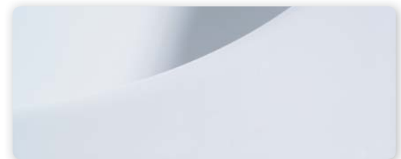
Acrylate after repair | Acryl nach der Reparatur
